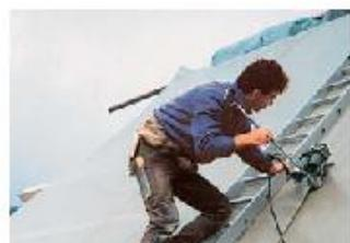
**X84** kof zavarivanja jedne folije za izolacije na strmom krovu. Uredaj X84 težak 6.1 kg uspešno savladjuje strmine ravnomernom brzinom.
