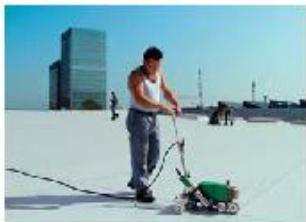
**VARIMAT V** kod preklopnog zavarivanja krovnih elemenata od plastike.
