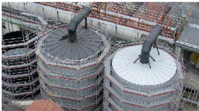
13 metara visok silos od HD-PE, Španija
