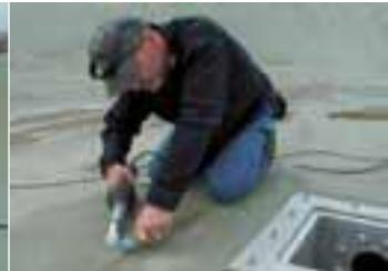
Verschweißen der Anschlüsse mit TRIAC PID mit aufgeschobener Breitschlitzdüse.
