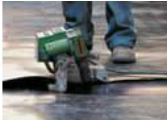
TWINNY T mit Kombikeil beim Verschweißen einer HD-PE-Dichtungsbahn.
